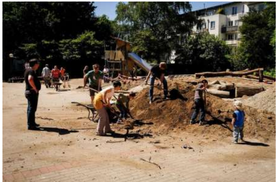
Ein Großteil des Materials wurde mit Schubkarren bewegt.
